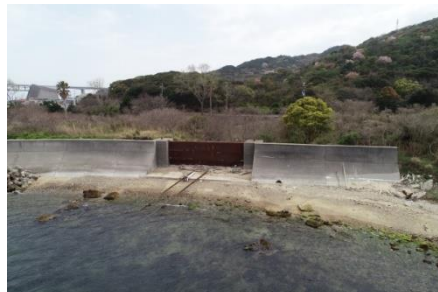
写真 1 保全堤防の陸閘
